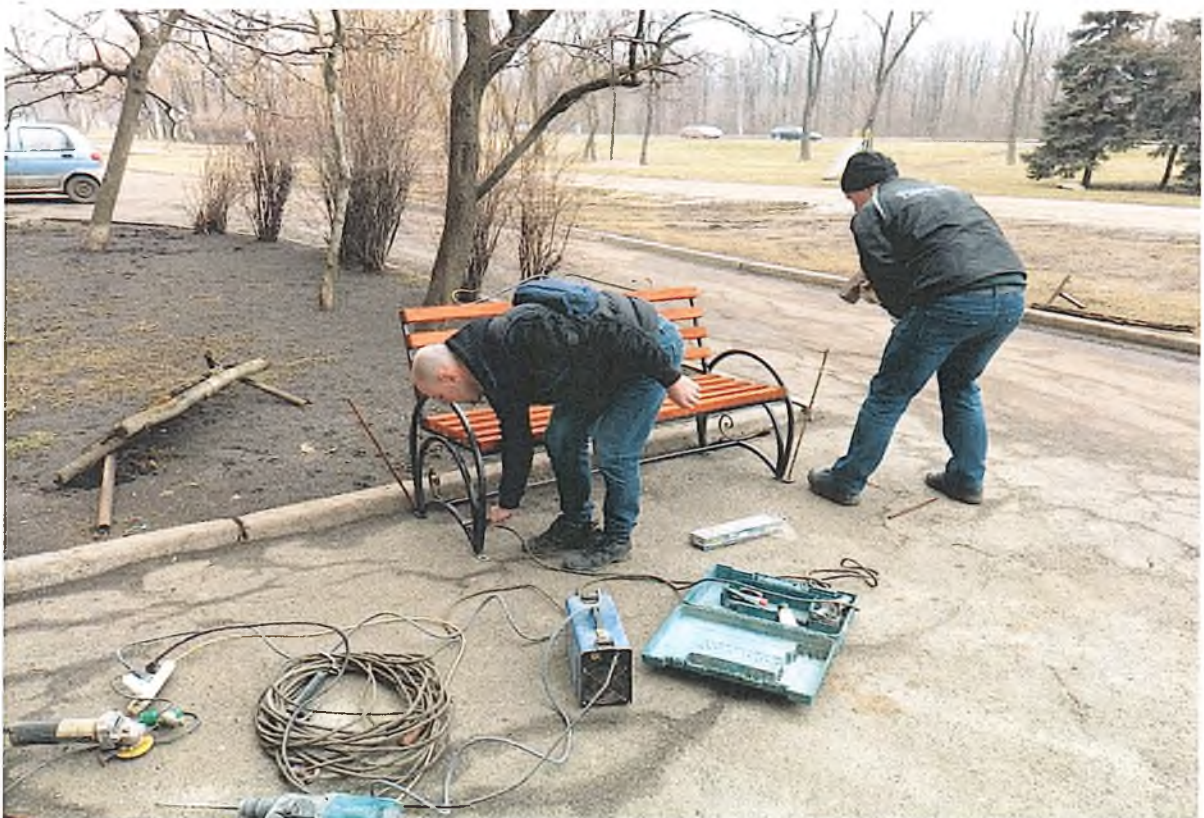
Встановлення лавок біля будинку №46 по вул. Дніпровське шосе
