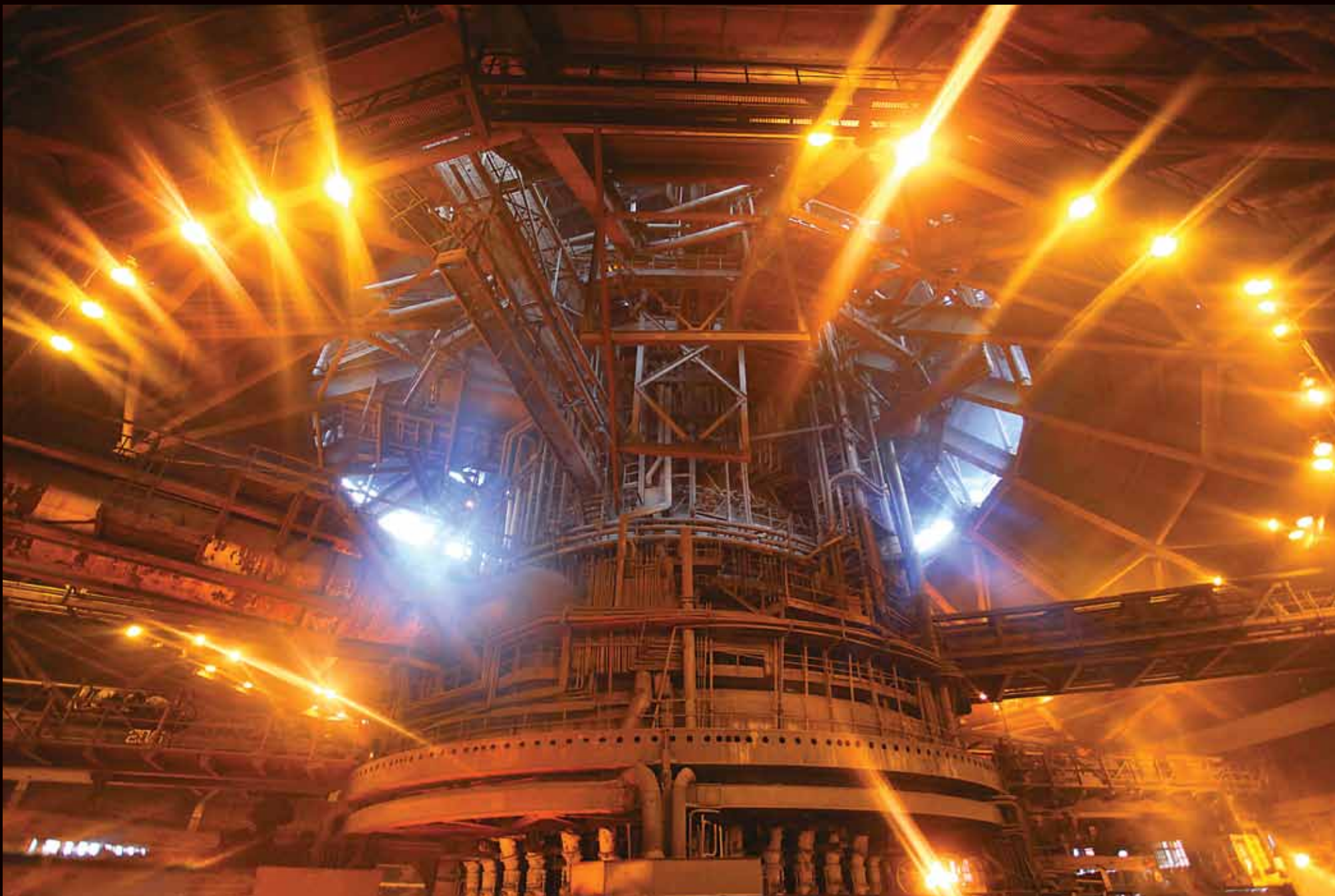
Доменна піч № 9 ПАТ «АрселорМіттал Кривий Ріг» • Blast-furnace № 9 of the AMKR (ArcelorMittal Kryvyi Rih) public corporation
