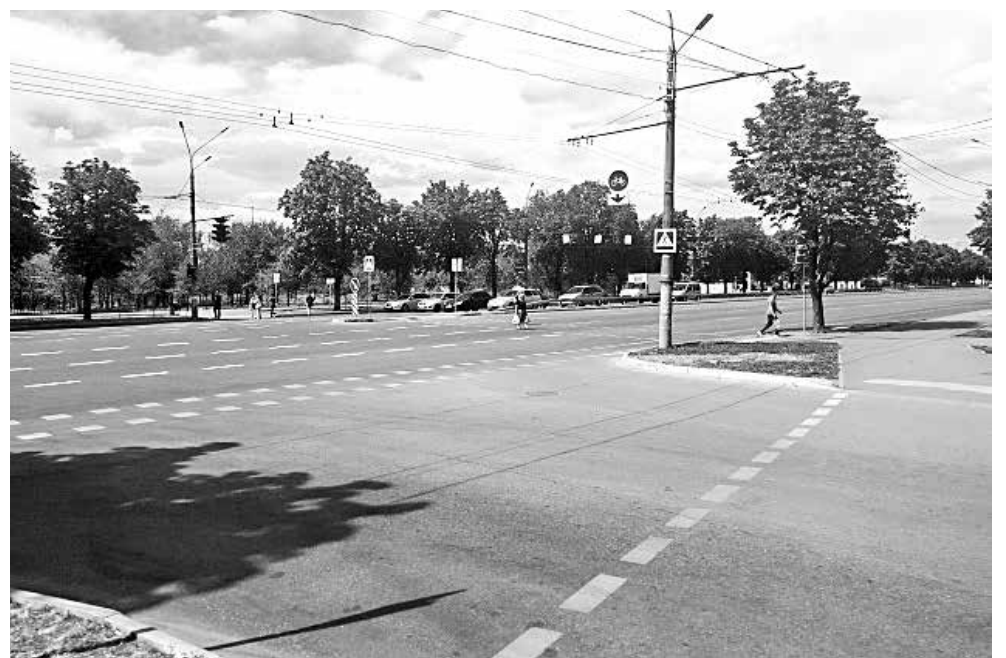
Капітальний ремонт дороги вул. Сергія Колачевського Капітальний ремонт дороги на проспекті 200-річчя Кривого Рогу
