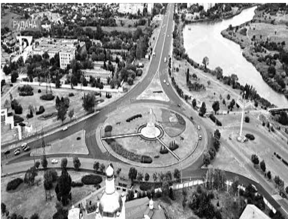
Капітальний ремонт дороги на проспекті 200-річчя Кривого Рогу від площі 30-річчя Перемоги до вул. Спаської в Саксаганському районі
