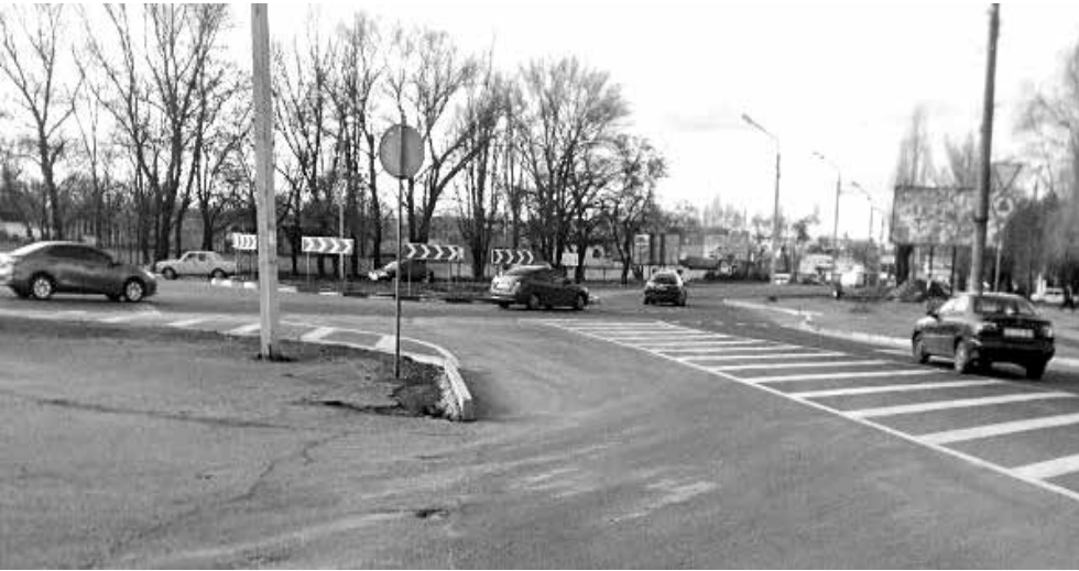
Капітальний ремонт дороги на проспекті 200-річчя Кривого Рогу вул. Спаської до вул. Едуарда Фукса
